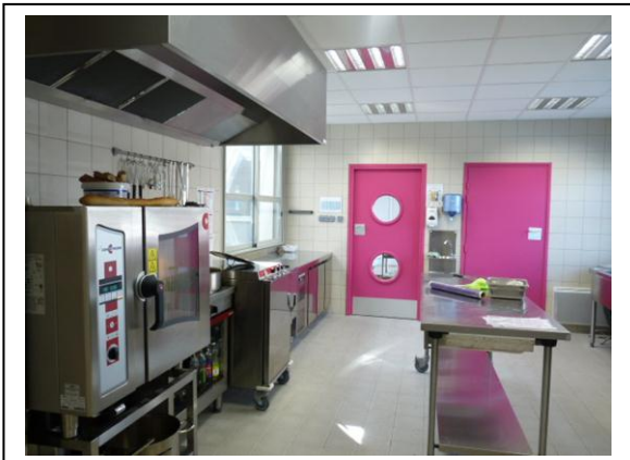
Cuisine fabrication des repas sur place
